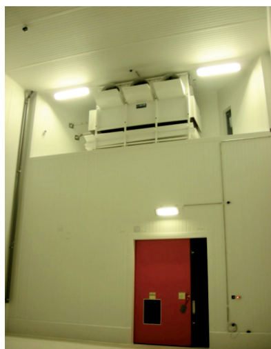
Рис. 5. Воздухоохладитель, размещенный на высоте 6 м в нише над коридором уменьшенной высоты
