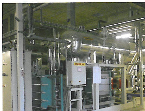
Face à ce groupe (Mycom) on distingue dans le fond la bache MEG et les pompes de distribution. Le condenseur à plaque NH 3 /MEG est visible derrière l'armoire électrique. Au dessus du groupe également le ballon BP avec en dessous l'évaporateur à plaque. Au centre : l'automate embarqué Siemens.
