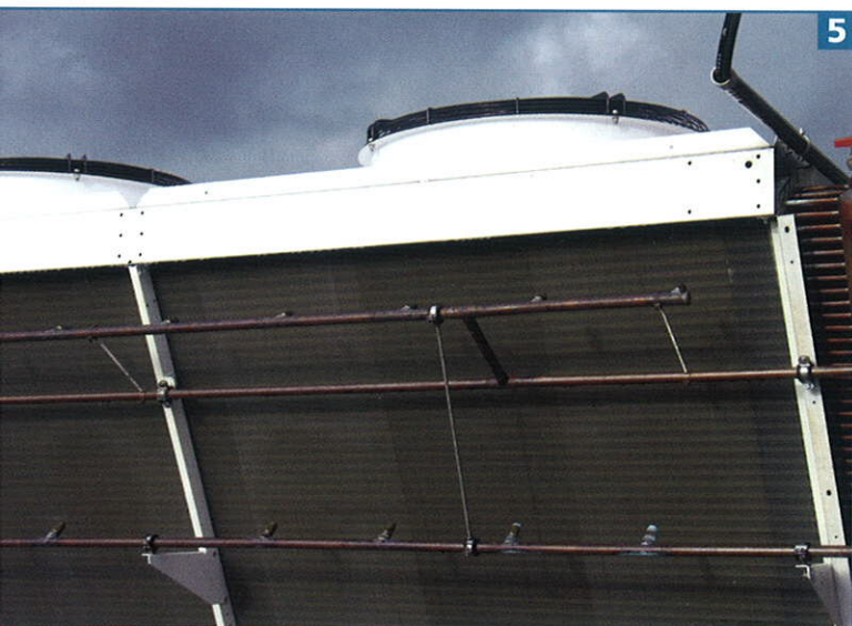
5. UN PARTICOLARE DELLE RAMPE DI RISCALDAMENTO PER LO SPRUZZAMENTO D'ACQUA SULLE BATTERIE DI UNO DEI RAFFREDDATORI DI LIQUIDO. LO SPRUZZAMENTO VIENE ATTIVATO AUTOMATICAMENTE QUANDO LA TEMPERATURA DELL'ACQUA ESTERNA SUPERA UN VALORE PREDEFINITO (LU-VE CONTARDO).
